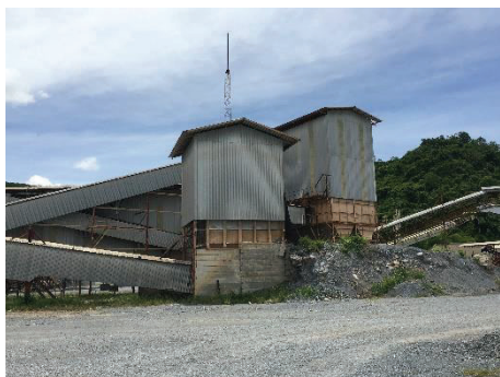
รูปที่ 2-9: การปิดคลุมอาคารโรงโม่
